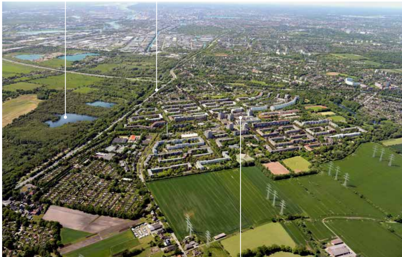
Einkaufszentrum Mümmele mit U-Bahnstation
