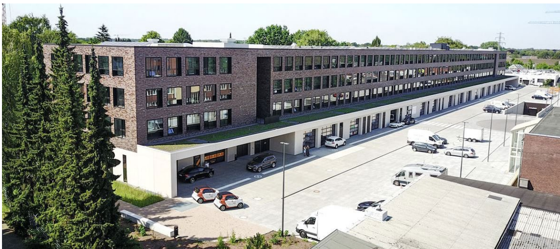
Ansicht Meistermeile © HWK Hamburg / ISOHAUS Bedachungen GmbH & Co KG
