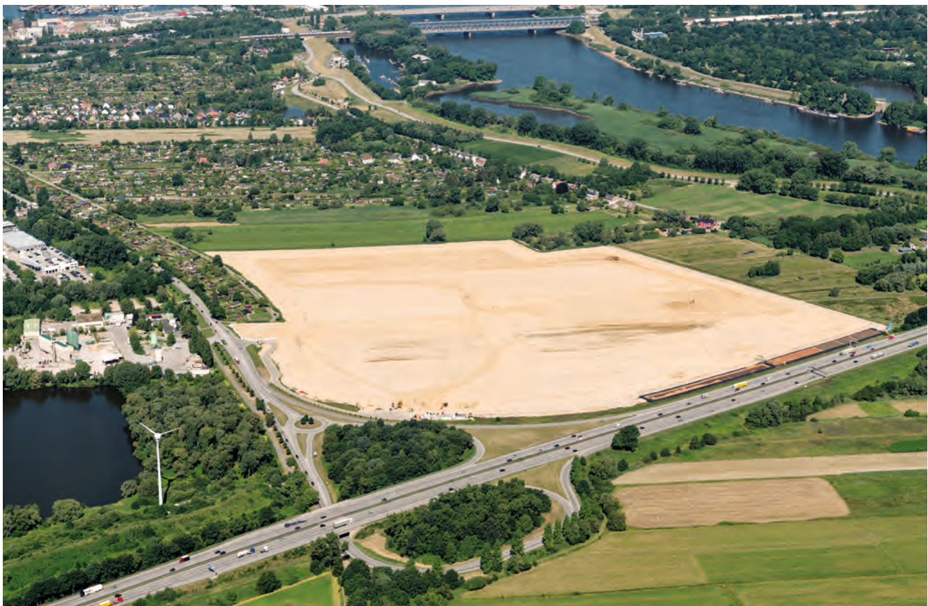
Erdarbeiten für einen innovativen Logistikstandort direkt an der BAB 1-Anschlussstelle Harburg
