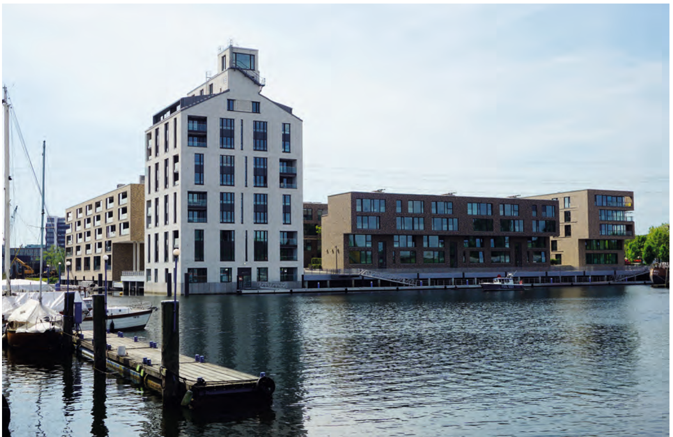
Beispiel für eine effiziente Flächennutzung: der Harburger Binnenhafen
