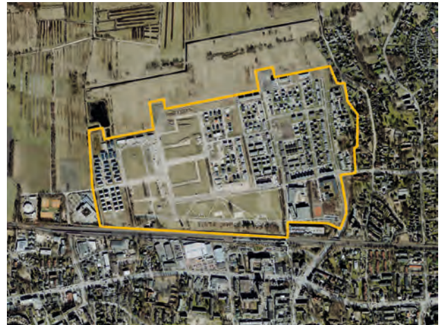
Das Quartier Vogelkamp Neugraben am Naturschutzgebiet „Moorgürtel“
