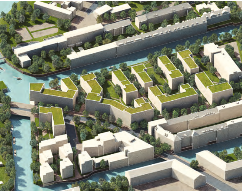
Neben Wohngebäuden soll hier unter anderem ein Quartiersbad entstehen
